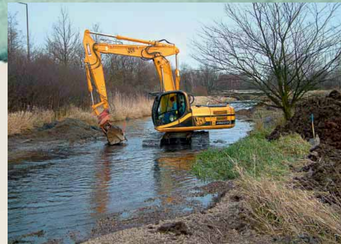
└ Verwandlung: Bis 2006 war die Aller ein kanalartig begradigter Wasserlauf. Seit dem Umbau des Flussbetts kann das Gewässer wieder seinem Lauf im gemäßigten Tempo folgen.
